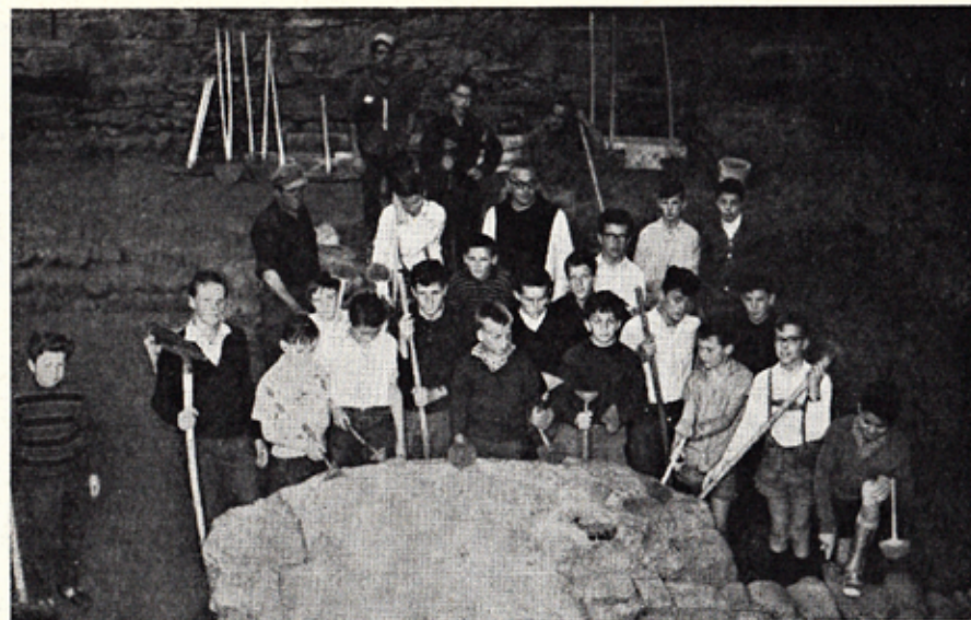
Die dritte Klasse half beim Reinigen der aufgefundenen Fundamente
